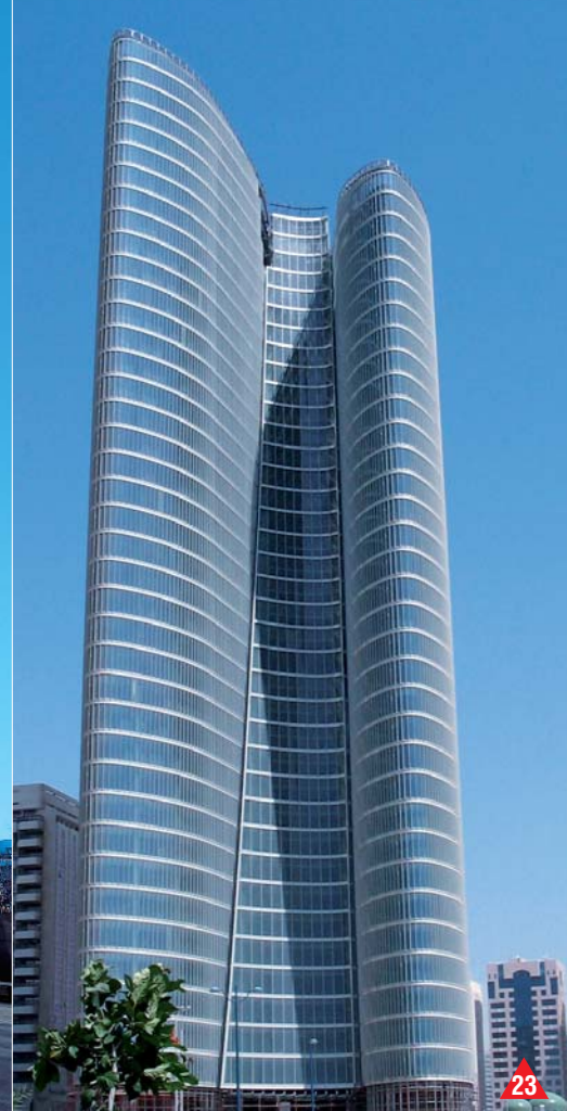
Adia épület, Abu Dhabi, Egyesült Arab Emírátsok; Kohn Pedersen Fox Associates PC
