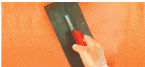
Közbenső réteg lezárása glettvassal
