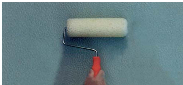
Struktúrált bevonat felhordása stuktúra hengerrel
