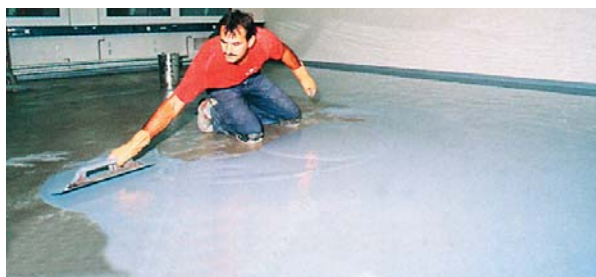
Önterülő anyag felhordása fogazott glettvassal
