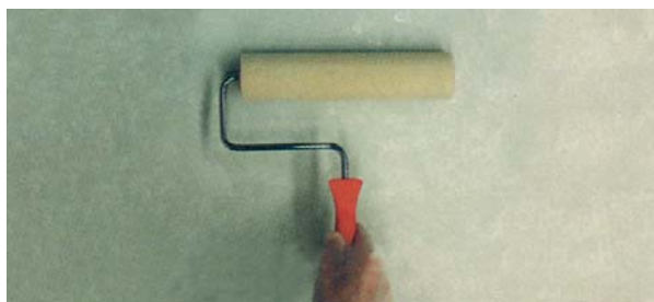
Matt fedőréteg felhordása rövidsálú hengerrel
