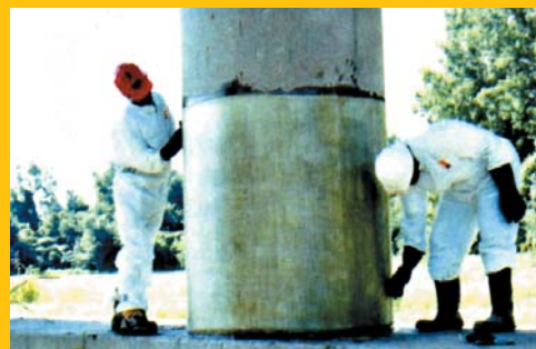
SikaWrap® üvegszálalas szövet alkalmazása
