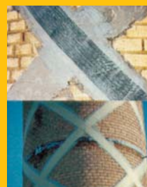
A szövet keresztezése és bevonatának elkészítése
