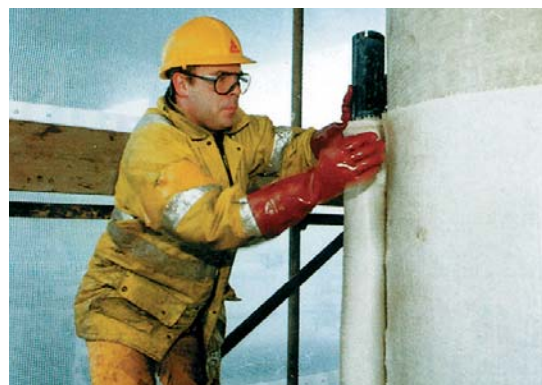
SikaWrap® szövetrendszer alkalmazása oszlop megerősítésére
